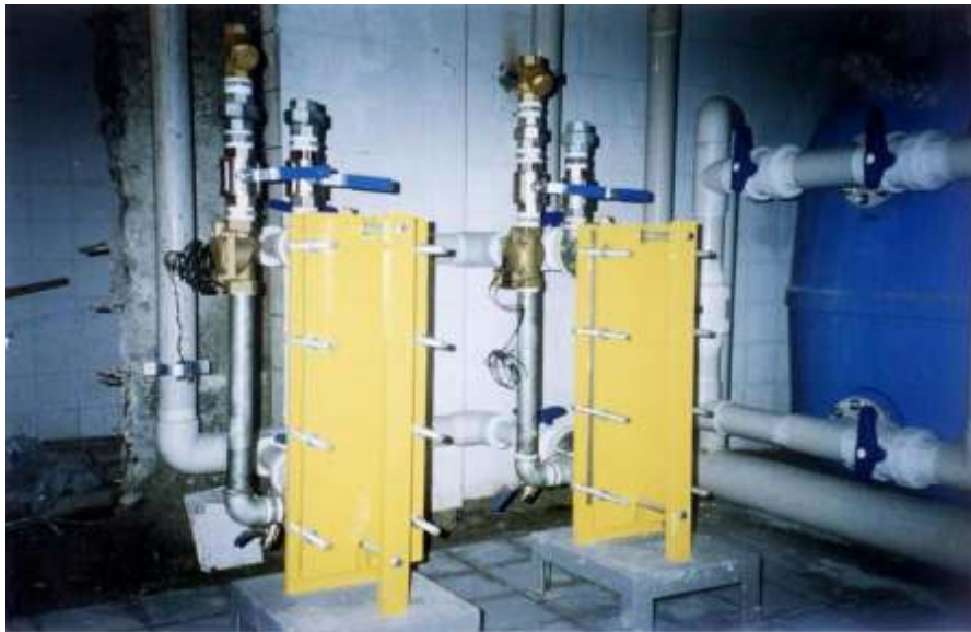
Paralel bağlanmış iki ısı eşanjörü :
